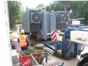
Mise en place d'un transformateur de 63 kV
